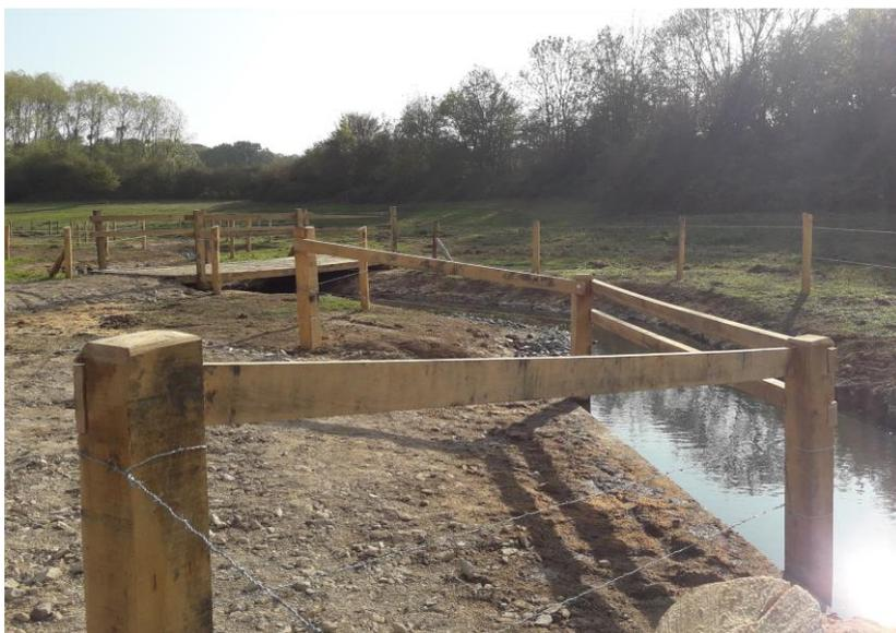
*Aménagements sur le nouveau lit, abreuvoir type descente aménagée, clôture barbelée, passage à gué pour le passage des engins et passerelle bois pour le passage du bétail. Le Palais - Commune de Chemiré en Charnie*
