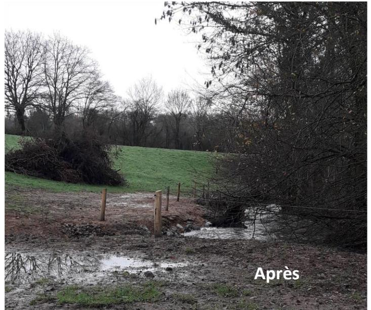
*Exemple de travaux sur berges avec apport de matériaux terro-graveleux et mise en place d'une clôture électrique.
